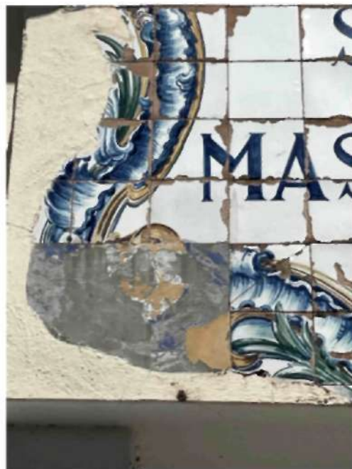
Fotografias 7 e 8. Presença de massas de cimento e novos azulejos industriais brancos aplicados numa anterior tentativa de restauro.
