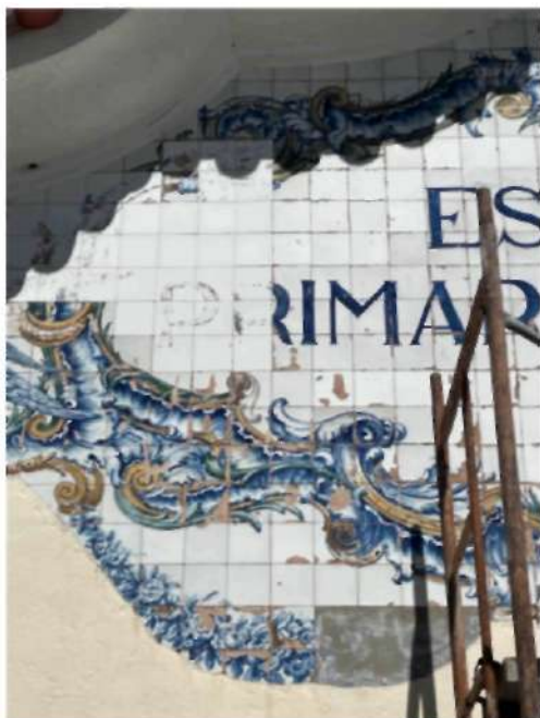
Fotografias 7 e 8. Presença de massas de cimento e novos azulejos industriais brancos aplicados numa anterior tentativa de restauro.
